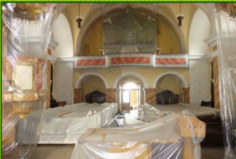
Přípravné práce před rekonstrukcí elektroinstalace v kostele sv. Martina
